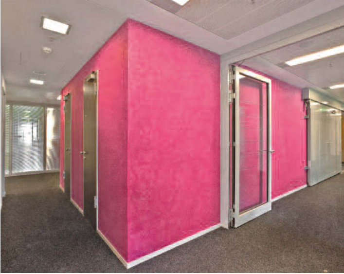
5 + 6 Bei der Applikation von FantasticFleece ist Genauigkeit gefragt: Überall, wo Wände und Flächen im rechten Winkel aufeinander treffen, schreiben die Verarbeitungsrichtlinien von Caparol Eckschienen vor, um einen exakten Anschluss zu erhalten. (Fotos: Caparol Farben Lacke Bautenschutz/Martin Duckek)
