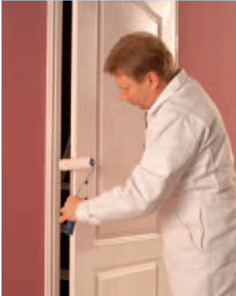
7 Türkante in einem Zug mitbeschichten.
