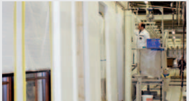
Beschichtungen für Fertighaus-Elemente zur Gestaltung und Werterhaltung.
